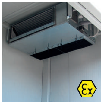
Aero evaporatore da soffitto realizzato con carenatura in alluminio goffrato completo di batteria in tubo di rame con superficie radiante.
